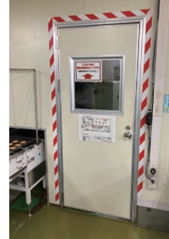
▲燃焼設備エリア入口の表示
